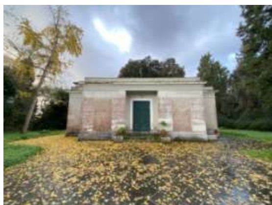
-Η πρόσοψη του κτηρίου
