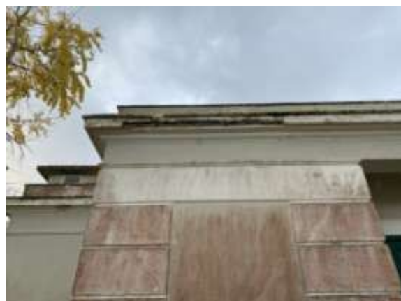
Λεπτομέρεια από την στέψη του κτηρίου
