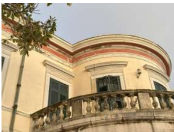
Λεπτομέρεια από την στέψη του κτηρίου
