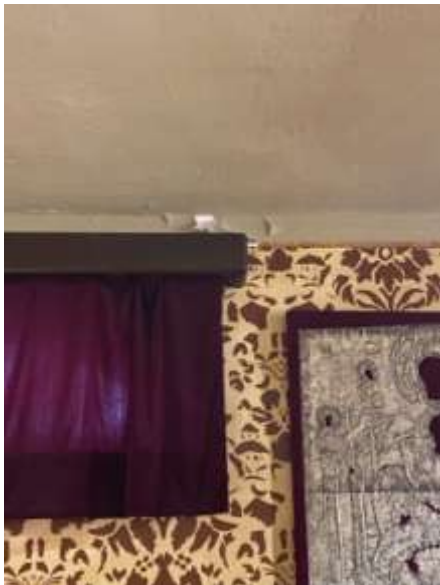
Λεπτομέρεια από τον γυναικωνίτη του κτηρίου
